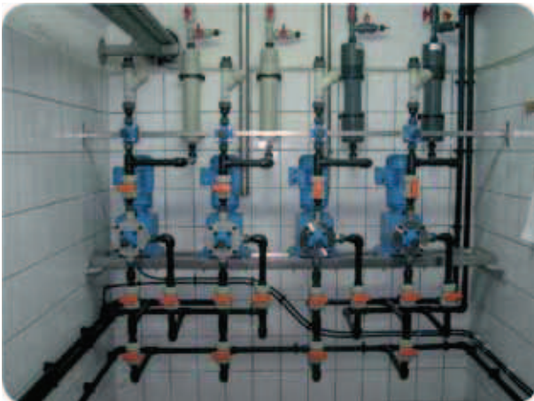
Instalacje technologiczne: kwasy, ług sodowy
