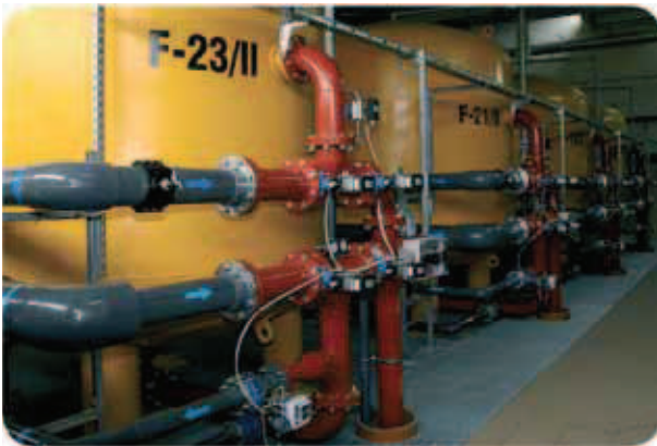
Instalacja stacji uzdatniania wody
