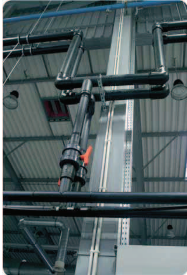
Instalacja wody chłodzącej i sprężonego powietrza
