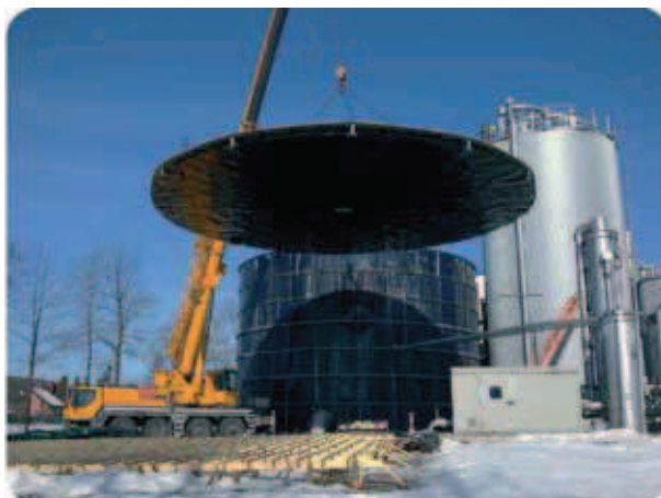
Montaż dachu stalowego z podwiązaniem płaszcza z PEHD
