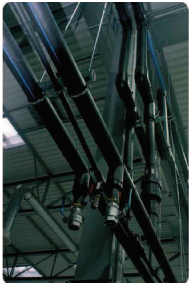
Instalacja wody chłodzącej i sprężonego powietrza
