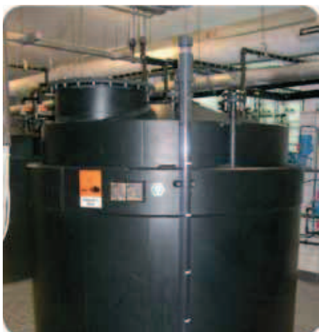
Rys. 2. Zbiornik na media żrące z wanną wychwytyjącą - rysunek poglądowy.
