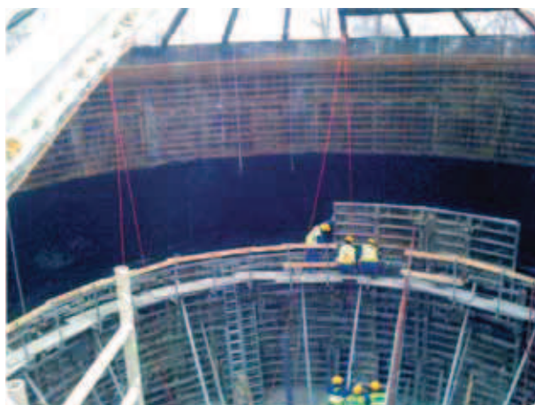
Montaż dachu stalowego z podwiązaniem płaszcza z PEHD
