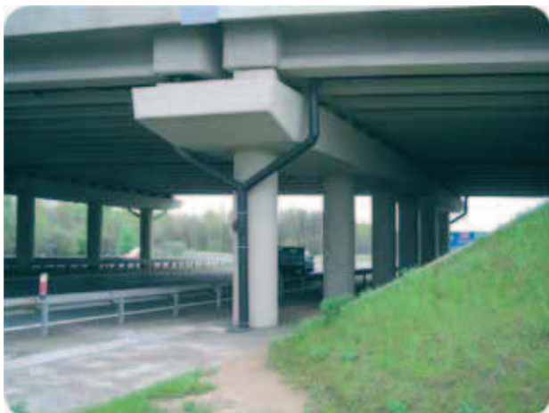
Przykładowy schemat wykonania odwodnienia mostowego.
